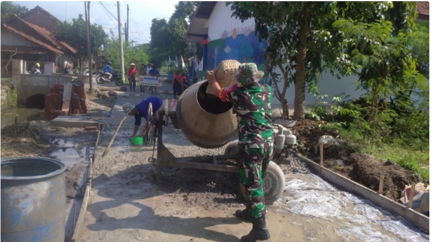
(Foto Istimewa) Pengecoran Jalan Di Dukuh Kepyar
